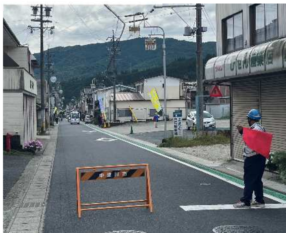
写真1 誘導員の配置
