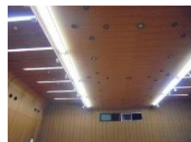
←新しく付け替えたLED 照明(両サイド)
