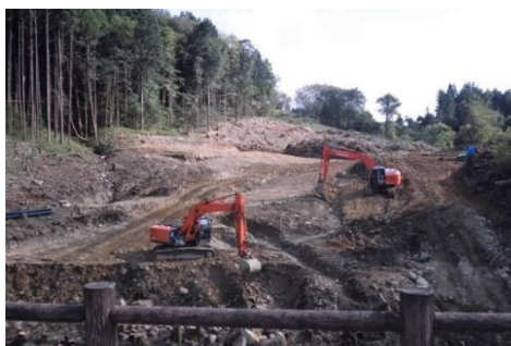
工事現場の様子
