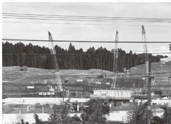
▲岐阜県駅（仮称）周辺の工事の様子
