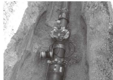
▲耐震化された水道管
