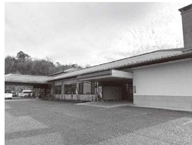
▲中津川市蛭川福祉センター、蛭川デイサービスセンター 蛭川ショートステイ事業所 ※1～3
