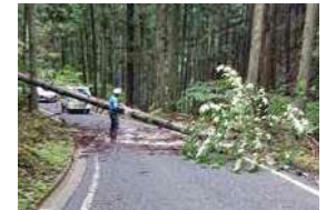
▲県道東野中津川線の倒木除去復旧作業
