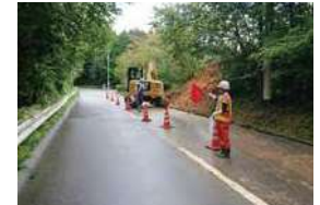
▲市道阿木3号線の復旧現場
