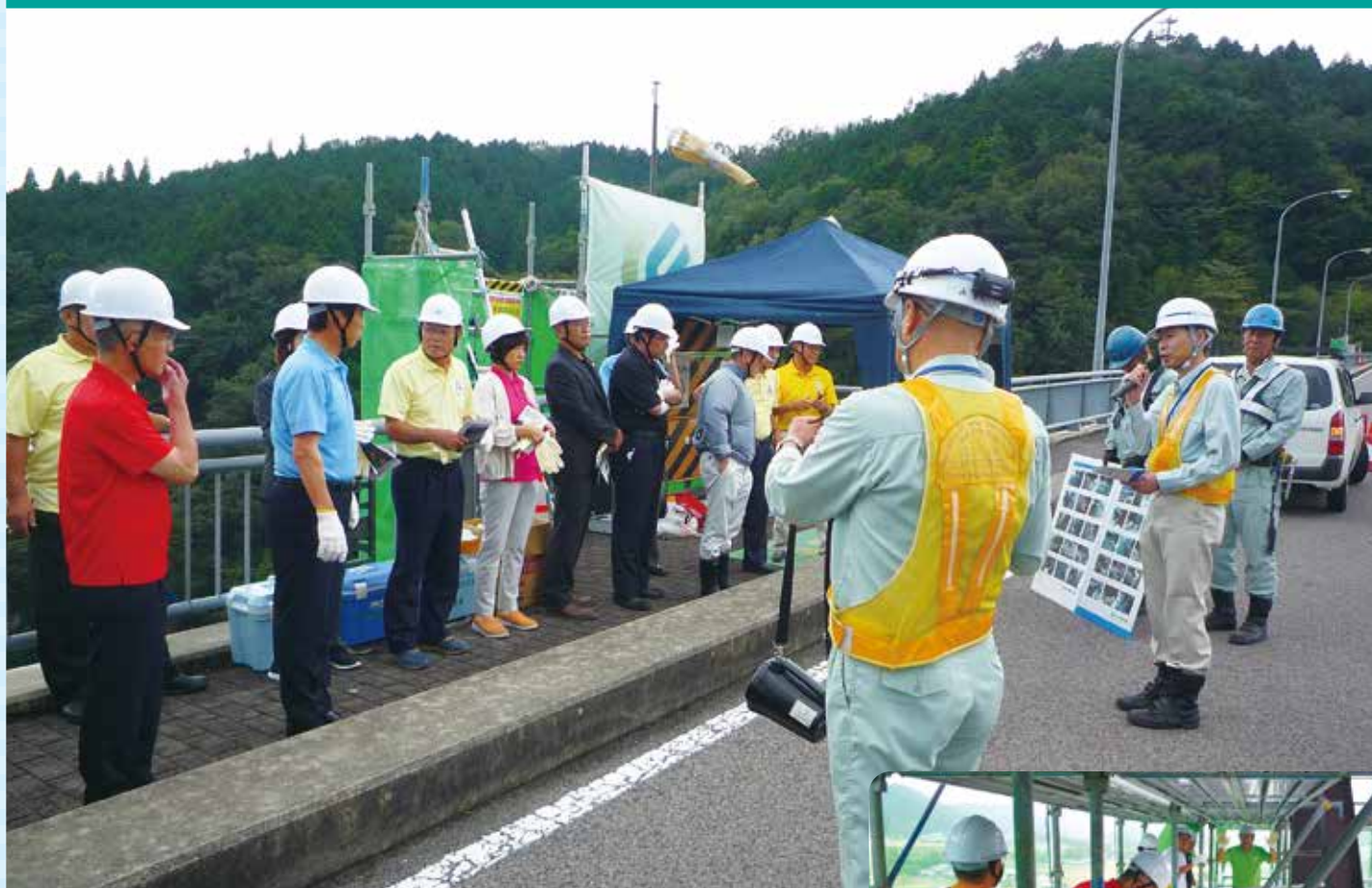
国土交通省・修繕代行事業 橋梁補修工事（乙姫大橋）の現場視察
