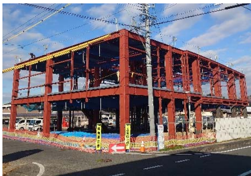
東濃5市消防指令センター建設状況
