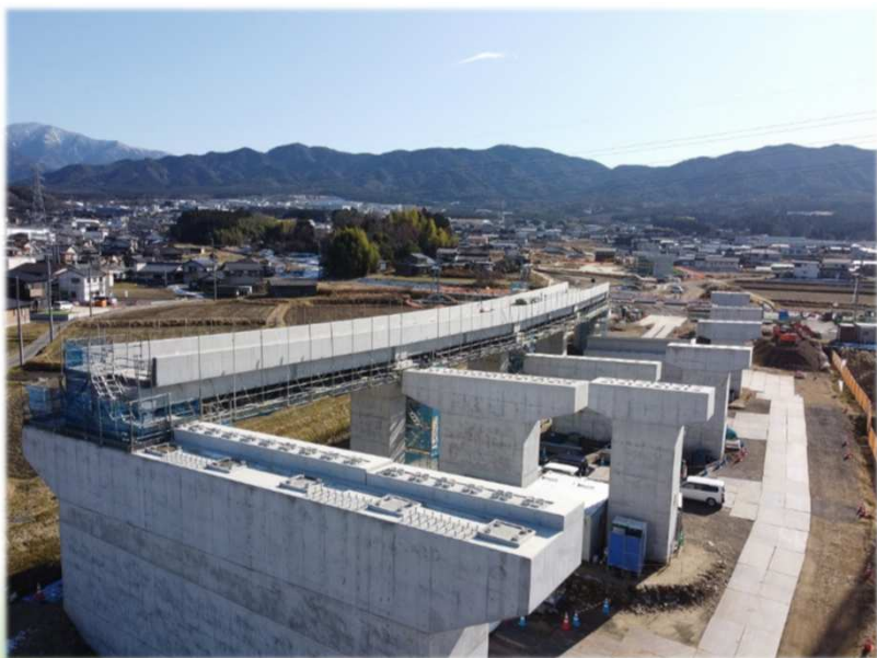
※① 濃飛横断自動車道整備の様子
