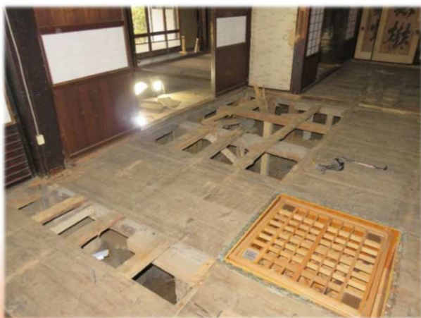
※① 落合宿本陣の補修の様子
