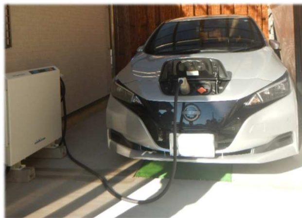
※② 導入された次世代自動車・V2H V2H：電気自動車やプラグインハイブリッド車に蓄えた電力を自宅でするシステム
