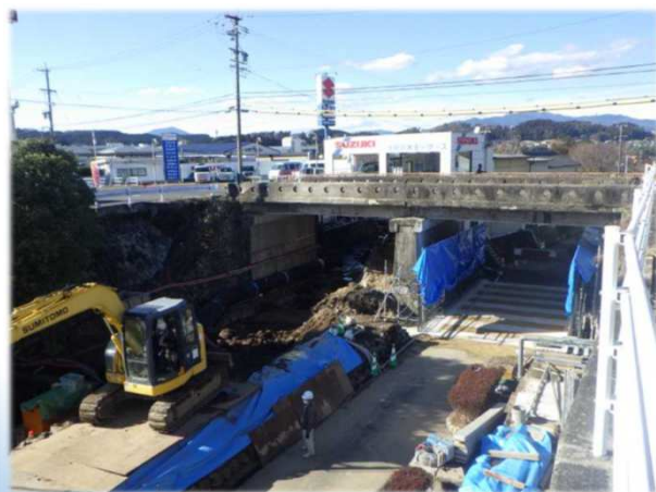
※① 橋りょう耐震補修工事の様子（黒沢橋）
