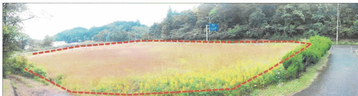
写真 2-2-2 瑞浪市内土岐町発生土仮置き場の現況
