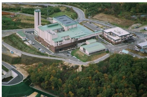
中津川市環境センター (平成 16 年(2004 年) 供用開始)
