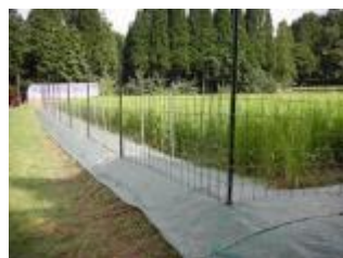
猪鹿無猿柵の設置状況（苗木地区）
