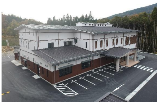
汚泥処理センター
