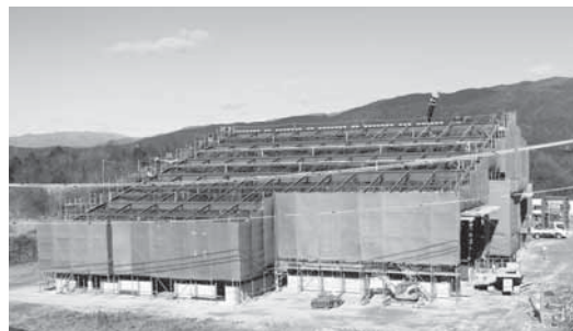
建設中のリサイクル施設
