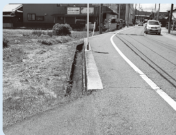
②堤下～野畔線歩道整備（坂本）
