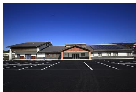
新築した苗木交流センター（苗木公民館）
