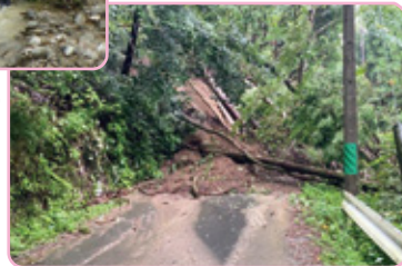
▲市道山口63号線の土砂崩れ現場
