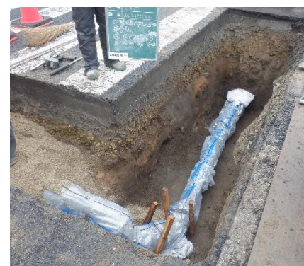
新しく布設した水道管
