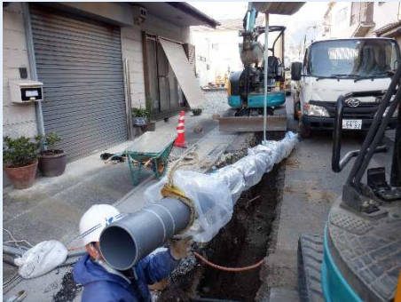
●中津川駅周辺管路更新工事
