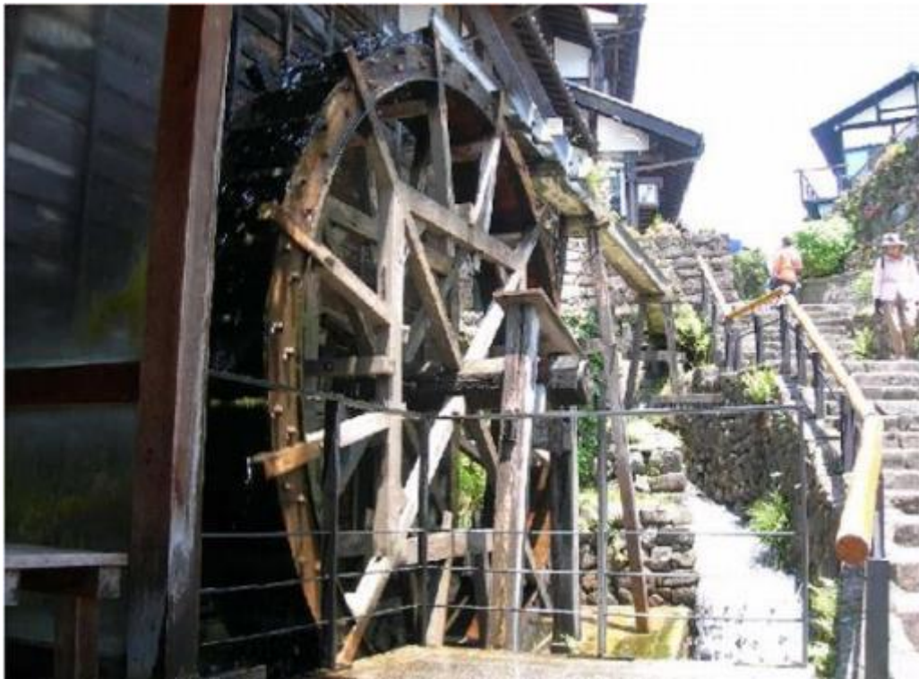
馬籠宿 小水力発電施設
