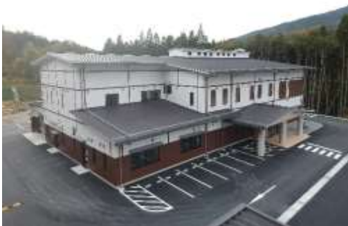
汚泥処理センター
