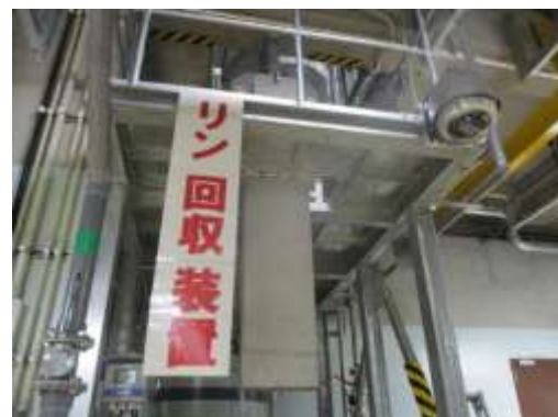
汚泥処理センター (内部)
