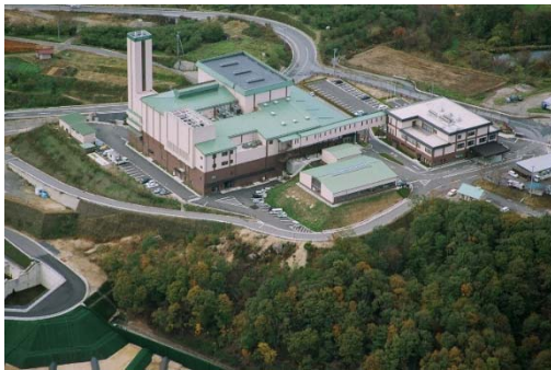
中津川市環境センター（平成16年供用開始）
