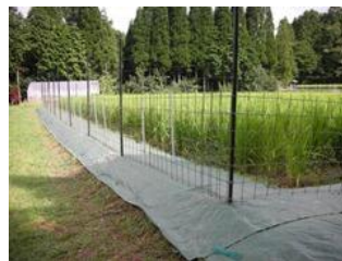
猪鹿無猿柵の設置状況（苗木地区）
