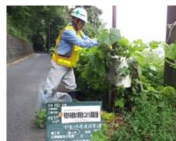
作業員によるアレチウリの除去
