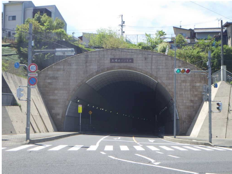
大明神トンネル
