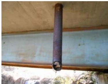
【損傷状況⑥】 腐食
