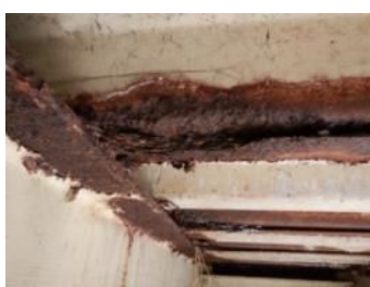
無名橋橋側歩道橋
