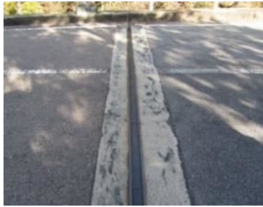
【損傷状況⑤】 伸縮部からの漏水
