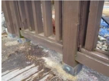
【損傷状況④】 腐食
