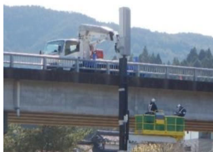
(従来) 点検車による点検状況
