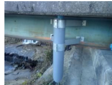
【対策事例⑥】 部材交換
