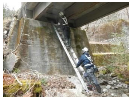
(従来) 梯子による点検状況
