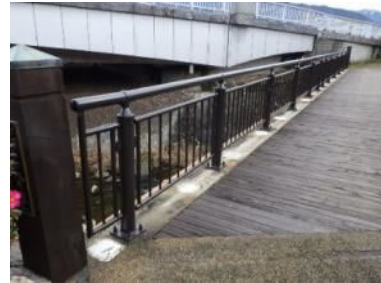
【対策事例④】 部材交換
