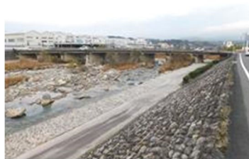
新中津川大橋(中津)
