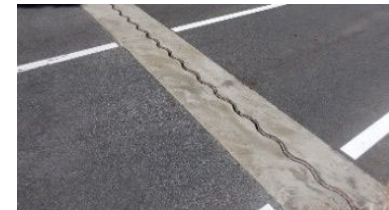
伸縮装置取替による主桁端部の予防
