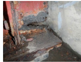
主桁端部の腐食
