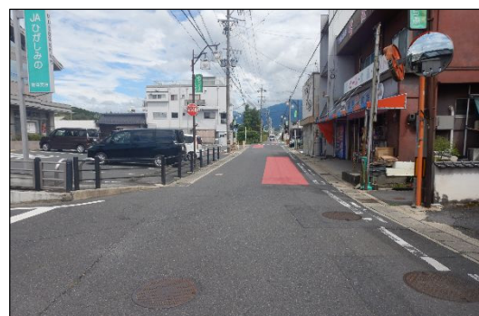
歩道と車道が分離されていない
