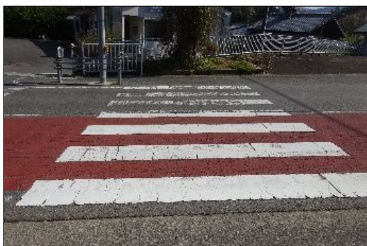
視覚障害者誘導用ブロックがない
