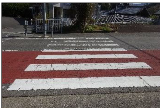
視覚障害者誘導用ブロックがない
