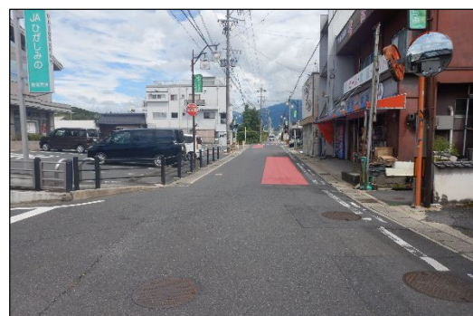
歩道と車道が分離されていない
