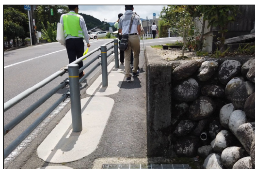
幅の狭い歩道
