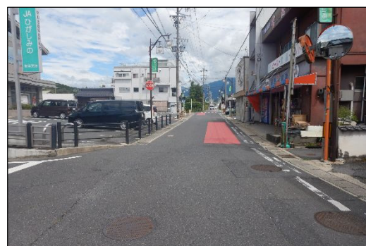
歩道と車道が分離されていない
