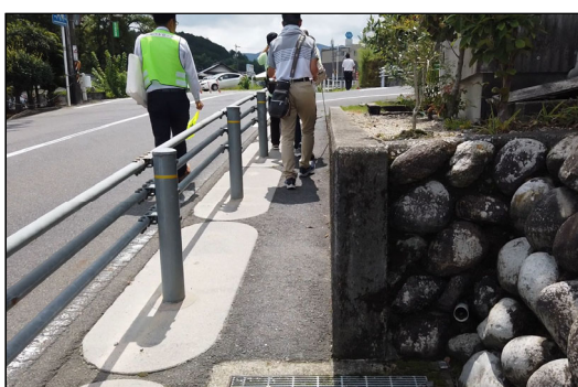
幅の狭い歩道
