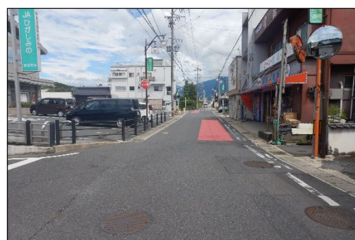
歩道と車道が分離されていない
