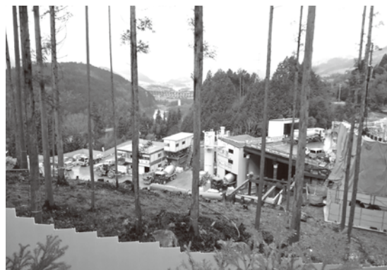
工事ヤード（作業場など）の様子（平成31年1月）
