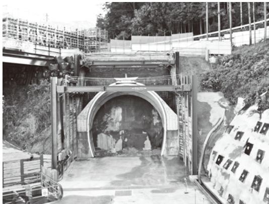
山口非常口斜坑トンネル坑口
