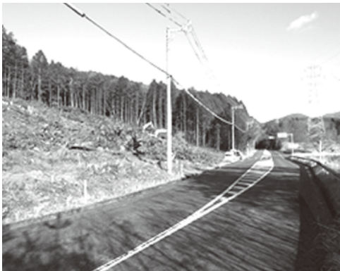
瀬戸非常口工事ヤード（着工後平成31年1月）
