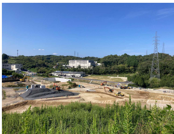
写真 盛土工（施工状況）
