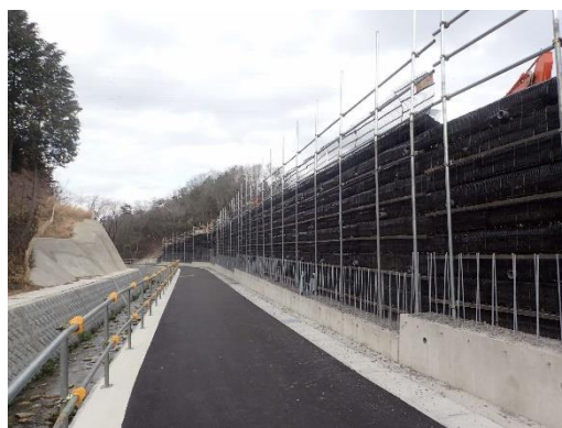
写真 擁壁工（施工状況）
