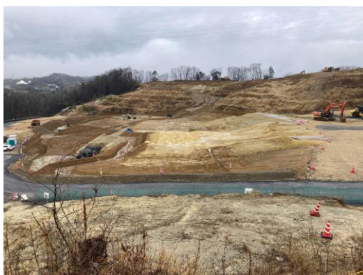
写真 盛土工（施工状況）
