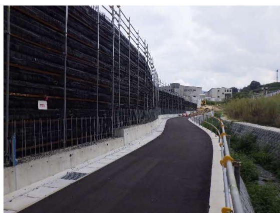
写真 盛土補強土擁壁工（施工状況）
