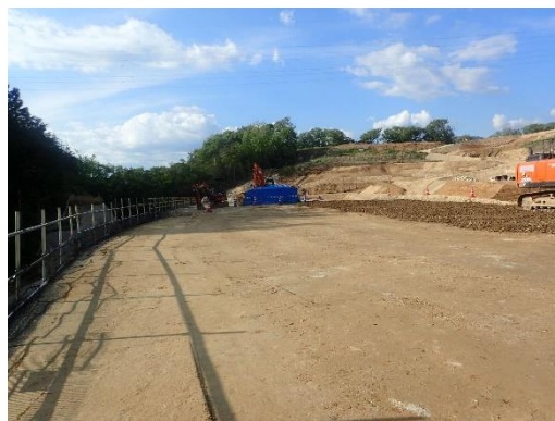
写真 擁壁工（施工状況）
