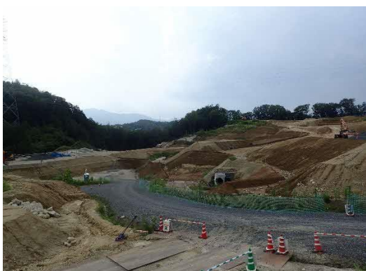
写真 盛土工（施工状況）
