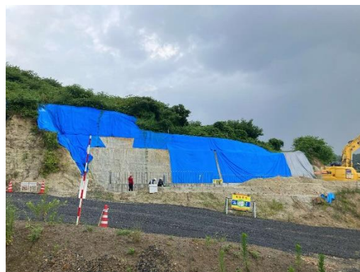
写真 盛土補強土擁壁工（施工状況）
