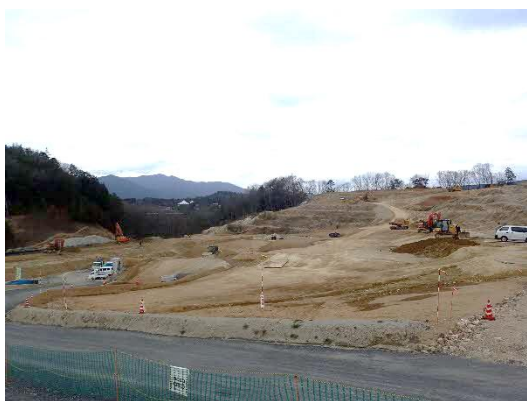
写真 盛土工（施工状況）
