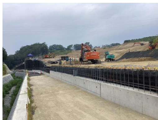
写真 盛土補強土工（施工状況）
