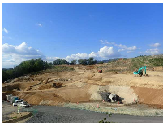
写真 盛土工（施工状況）
