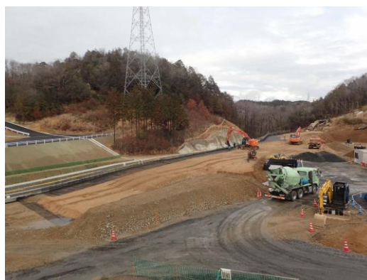
写真 擁壁工（施工状況）
