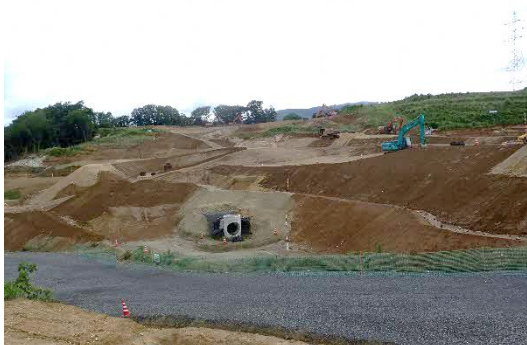
写真 盛土工（施工状況）
