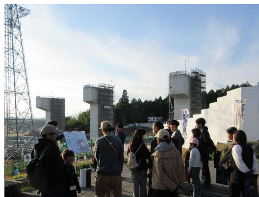
岐阜県駅(仮称)で現場を見ながら工事の進捗状況について説明を受けました
