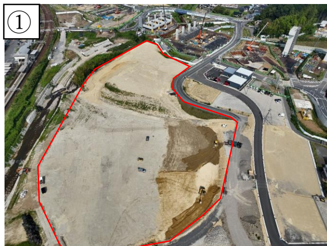
【状況写真 R7.8 月時点】
