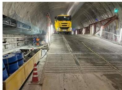
インバートコンクリート打設状況
