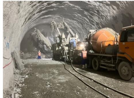
写真-1 吹付けコンクリート施工状況
