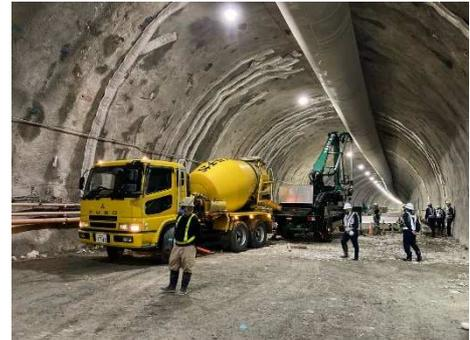
写真-1 インバート施工状況
