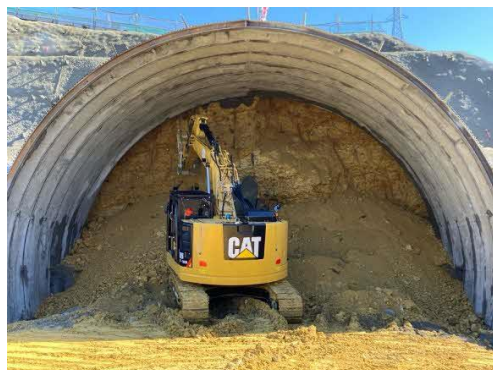
写真 トンネル掘削状況
