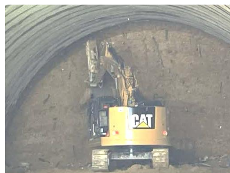
写真 トンネル掘削状況
