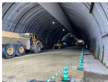
写真 トンネル坑内
