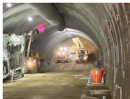
写真 トンネル坑内
