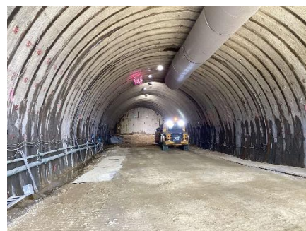
写真 トンネル坑内状況
