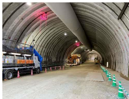
写真 トンネル坑内
