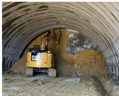
写真 トンネル掘削状況
