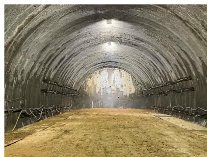
写真 トンネル施工状況
