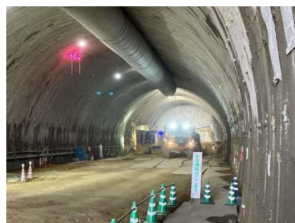
写真 トンネル坑内
