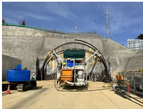
写真 トンネル坑口設置状況
