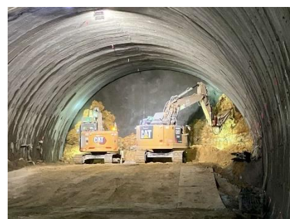
写真 トンネル坑内
