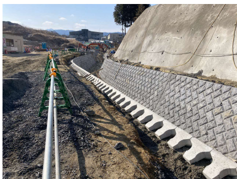
写真 河川付替え状況
