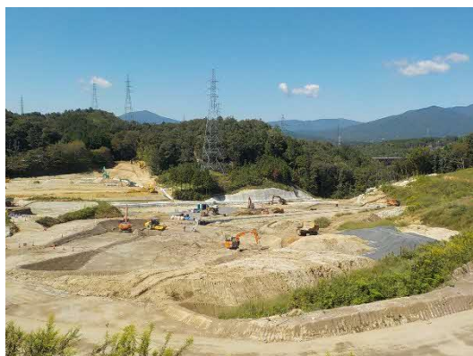
写真 盛土状況
