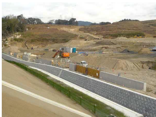
写真 擁壁工施工状況
