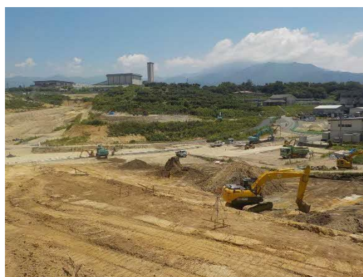
写真 資機材置場造成状況
