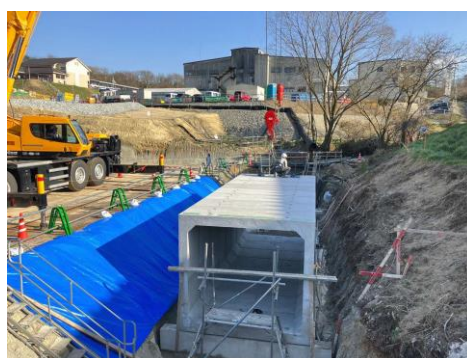
写真 ボックスカルバート施工状況
