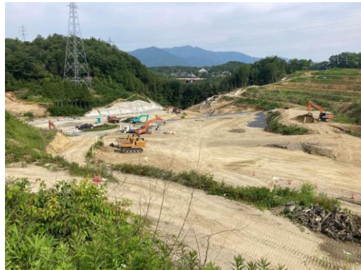
写真 盛土状況
