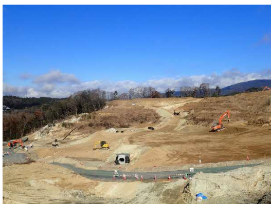
写真 盛土工（施工状況）
