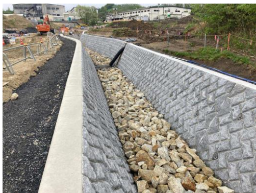
写真 河川付替え状況
