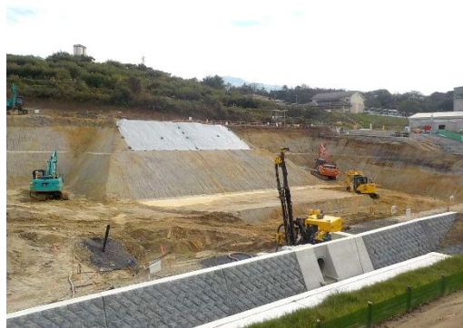
写真 調整池工施工状況
