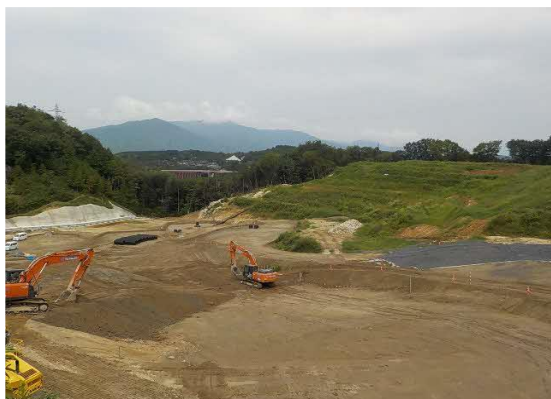
写真 盛土状況
