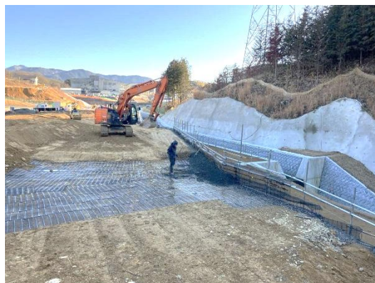
写真 擁壁工（施工状況）
