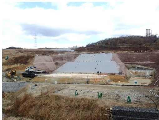
写真 調整池工（施工状況）
