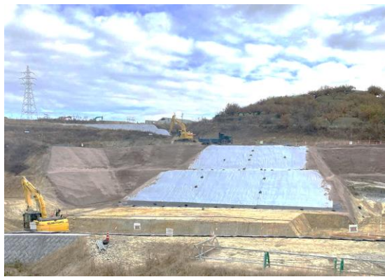
写真 調整池工（掘削完了）
