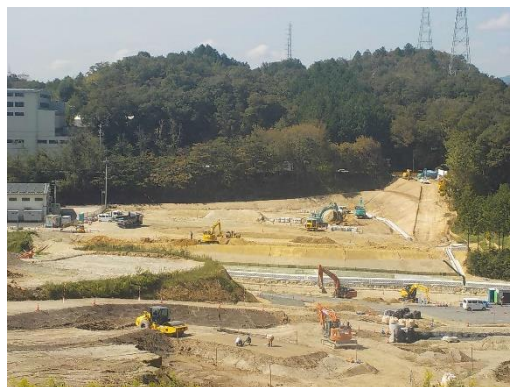
写真 資機材置場造成状況
