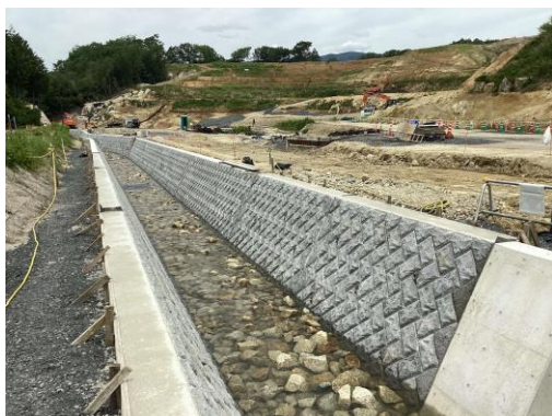
写真 河川付替え状況
