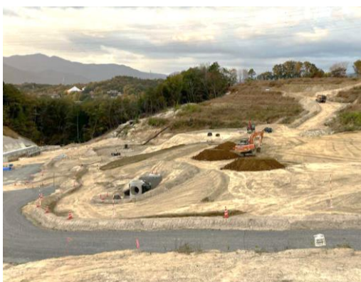
写真 盛土工（施工状況）
