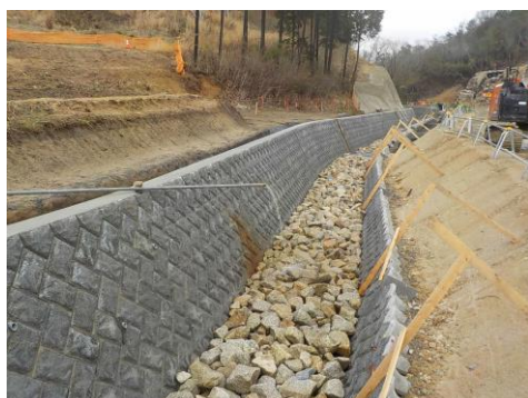
写真 河川付替え状況
