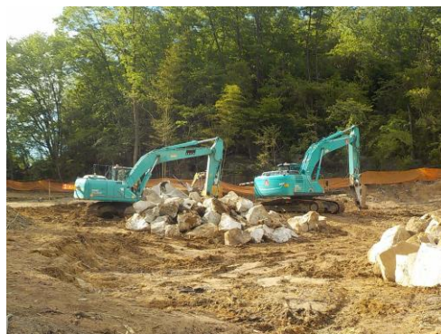
写真 資機材置き場巨石小割状況
