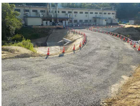
写真 渡河道路整備状況
