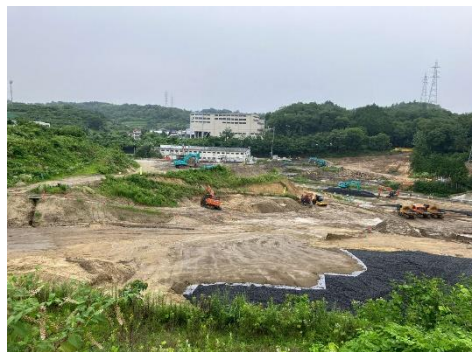
写真 盛土状況
