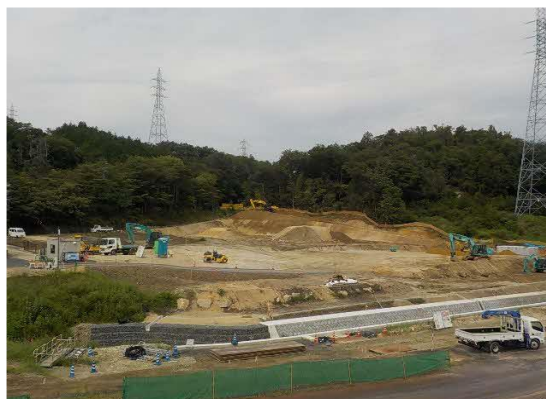
写真 資機材置場造成状況
