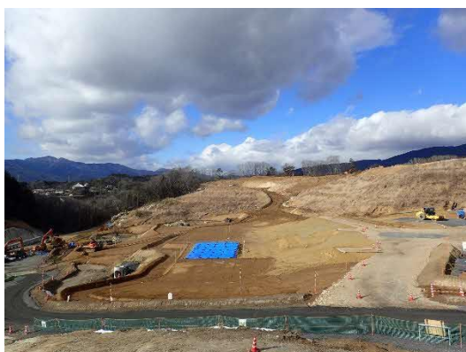
写真 盛土工（施工状況）
