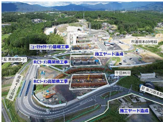
図 当月の主な工事範囲（駅東部）
