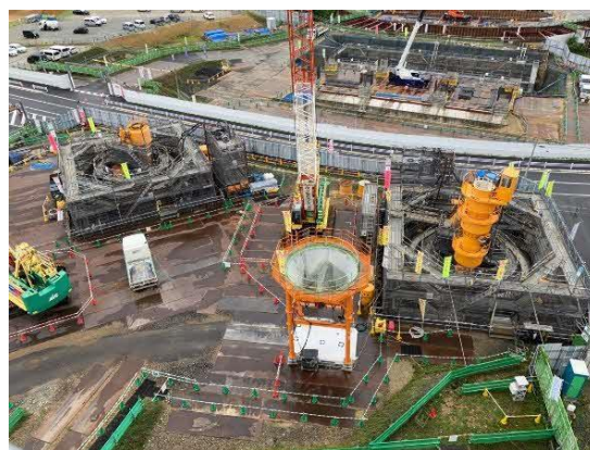
写真 ニューマチックケーソン基礎工事施工状況
