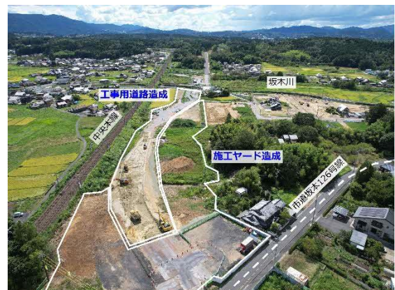
図 当月の主な工事範囲（駅中央部）
