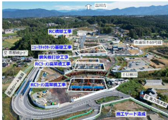
図 当月の主な工事範囲（駅東部）
