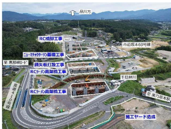
図 当月の主な工事範囲（駅東部）
