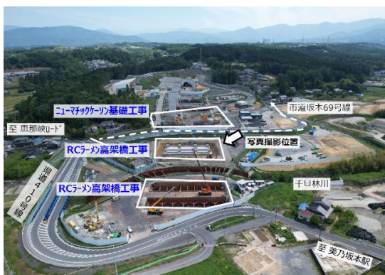
図 当月の主な工事範囲（駅東部）
