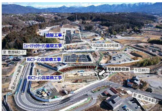
図 当月の主な工事範囲（駅東部）
