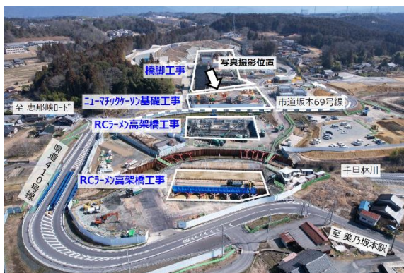
図 当月の主な工事範囲（駅東部）
