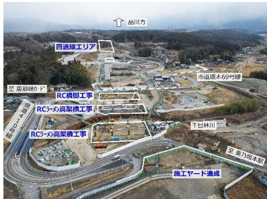
図 当月の主な工事範囲（駅東部）
