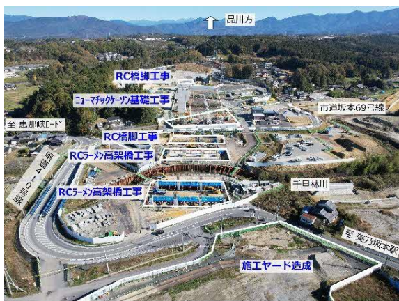
図 当月の主な工事範囲（駅東部）
