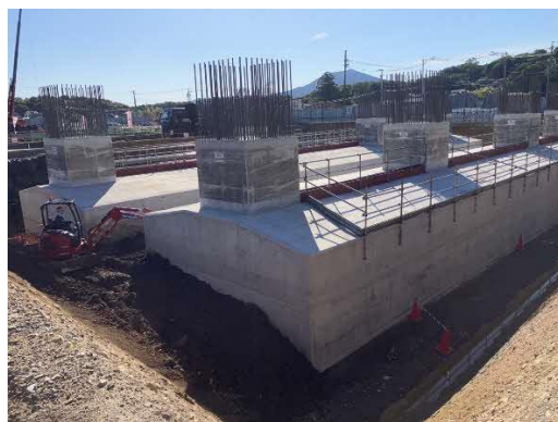
写真 RC ラーメン高架橋工事 基礎構築完了状況
