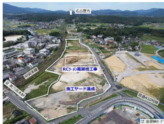
図 当月の主な工事範囲（駅中央部）
