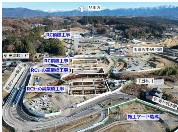
図 当月の主な工事範囲（駅東部）
