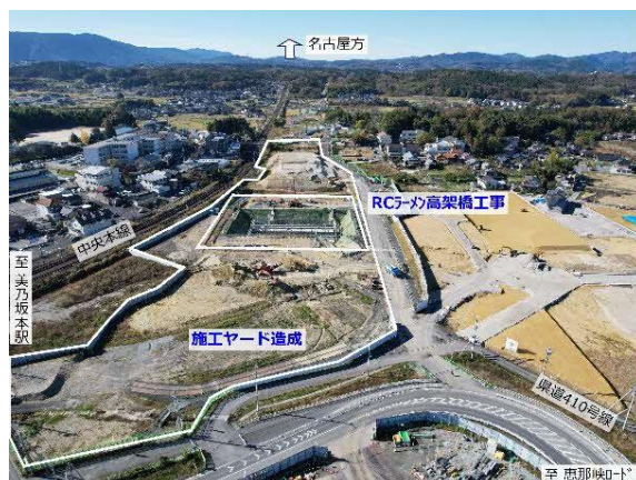
図 当月の主な工事範囲（駅中央部）
