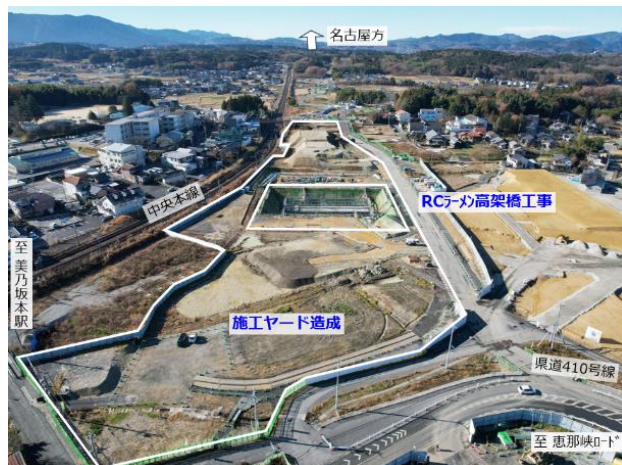
図 当月の主な工事範囲（駅中央部）
