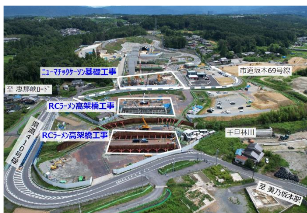
図 当月の主な工事範囲（駅東部）
