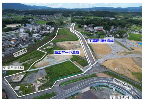
図 当月の主な工事範囲（駅中央部）
