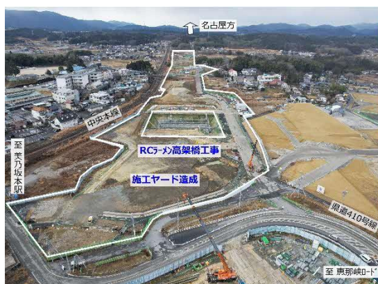
図 当月の主な工事範囲（駅中央部）
