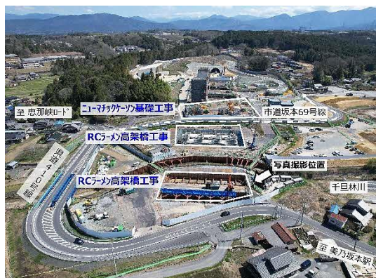
図 当月の主な工事範囲（駅東部）
