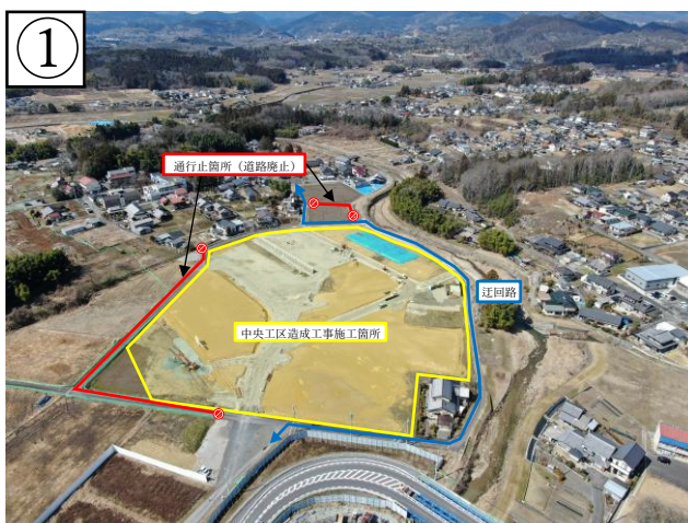
【状況写真 R6.3月時点】
