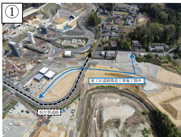
【状況写真 R6.4 月時点】
