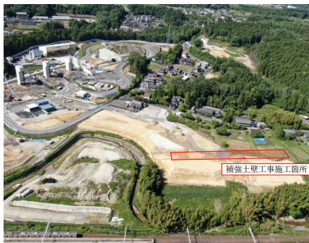
【状況写真 R6.5 月時点】
