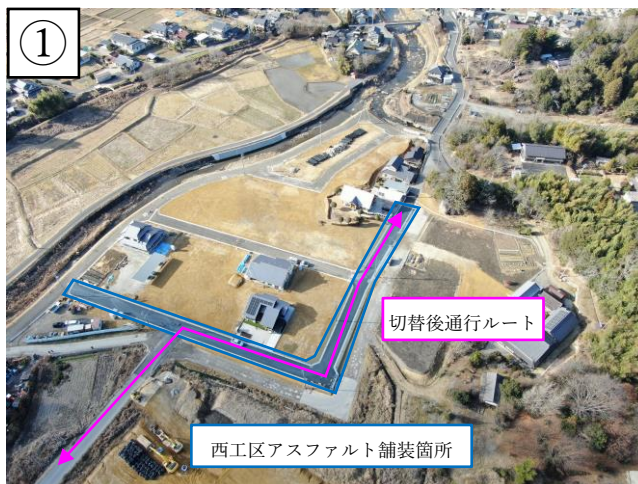
【状況写真 R7.1 月時点】
