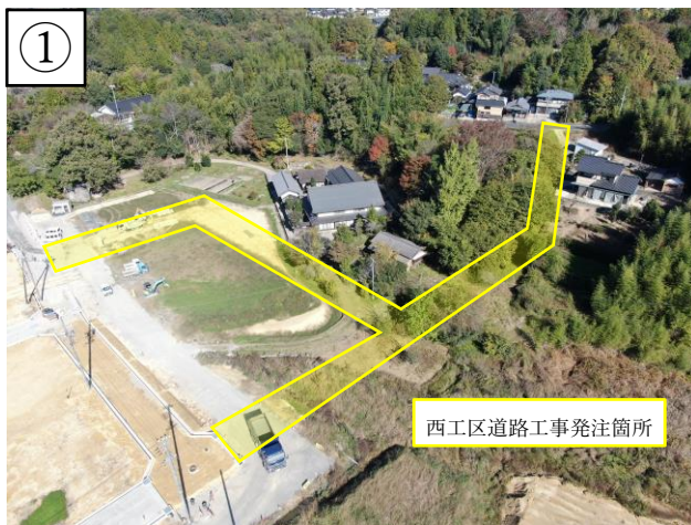
【状況写真 R6.11 月時点】
