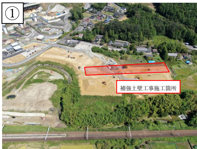
【状況写真 R6.9月時点】
