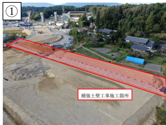
【状況写真 R6.10月時点】
