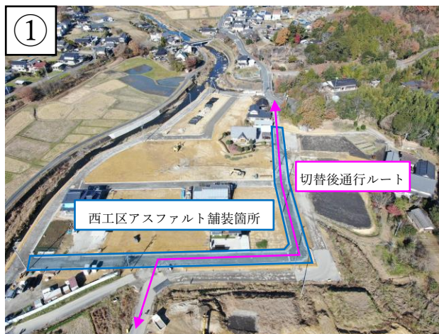
【状況写真 R6.12 月時点】
