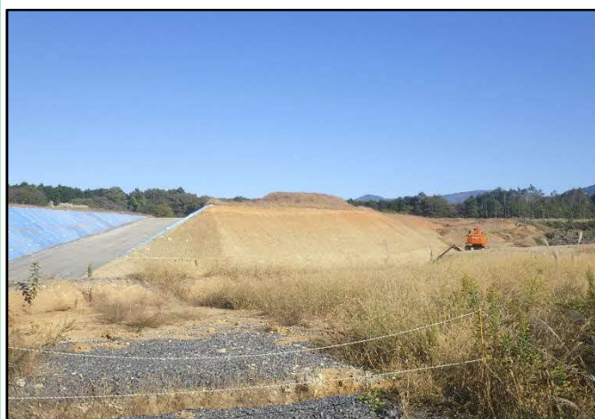
写真 切土エリア
