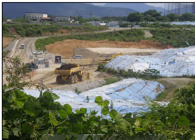
写真 表土埋め戻し
