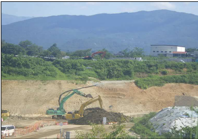
写真 表土埋め戻し
