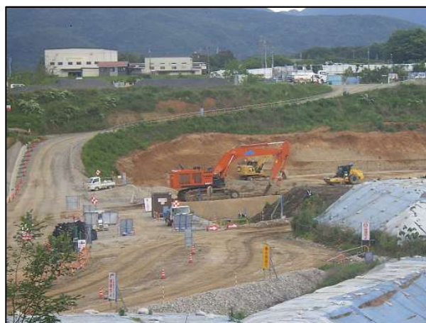
写真 表土埋め戻し
