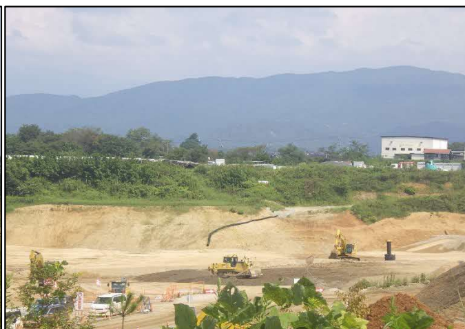
写真 表土埋め戻し
