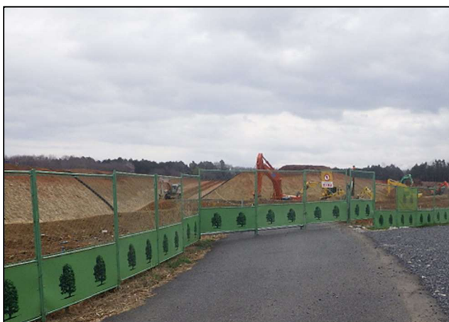
【施工状況・表土すきとり】
