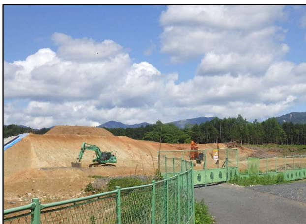
写真 表土すきとり
