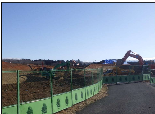
【施工状況・表土すきとり】
