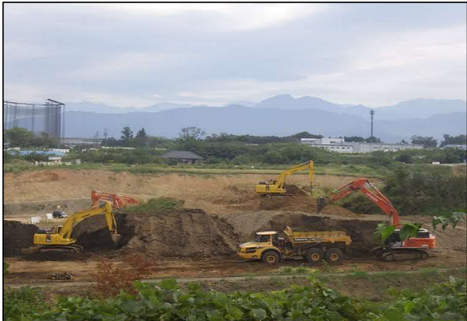
写真 仮置き表土積み込み
