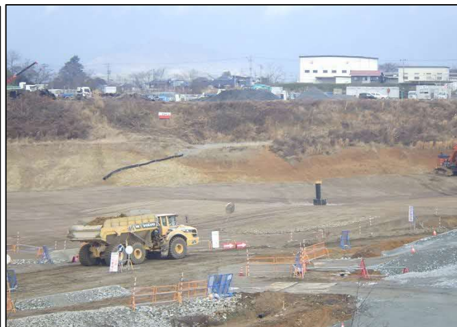
写真 仮置き表土運搬
