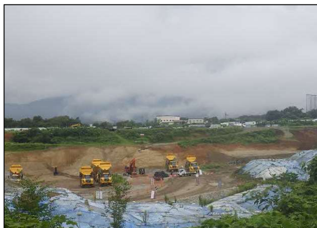
写真 表土埋め戻し
