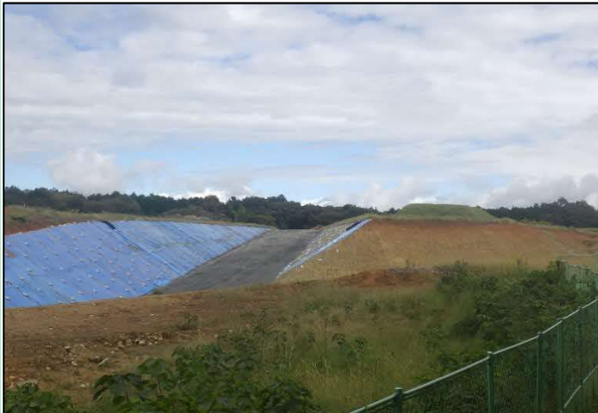
写真 切土エリア
