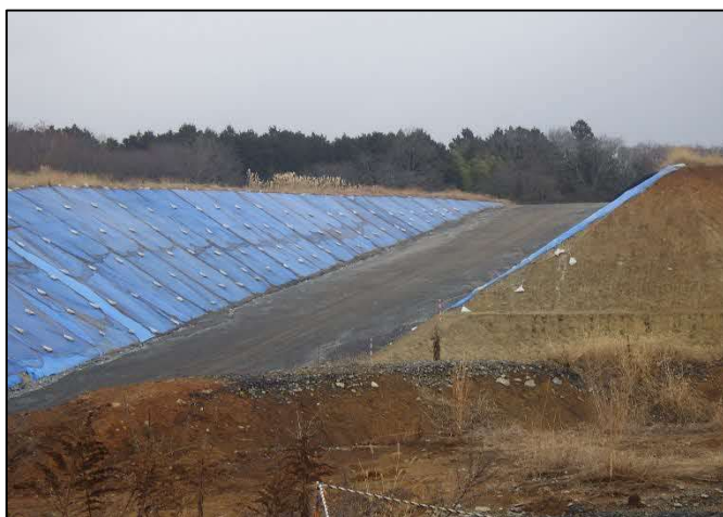
写真 切土エリア
