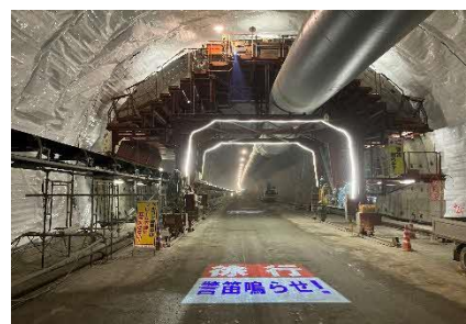
覆工コンクリート工事
