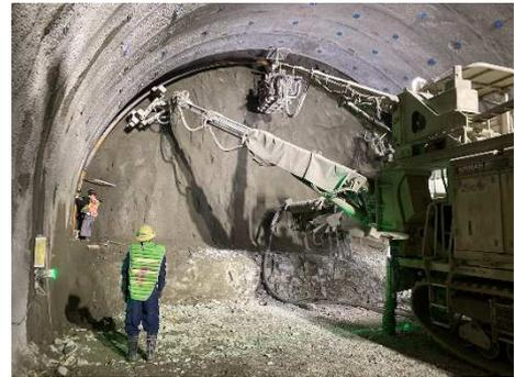
写真-1 鋼製支保工建込み状況
