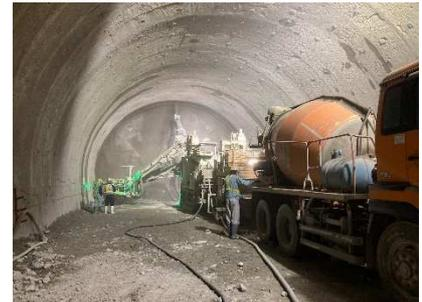
写真-1 吹付けコンクリート施工状況
