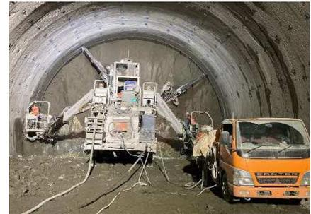
写真-1 ロックボルト打設状況
