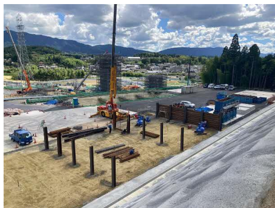
写真 発生土仮置場施工状況
