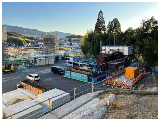
写真 トンネル設備設置状況
