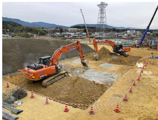
写真 路床改良施工状況
