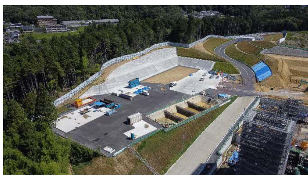
写真 ヤード造成状況
