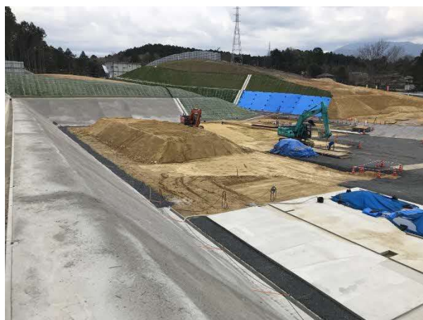
写真 ヤード舗装状況
