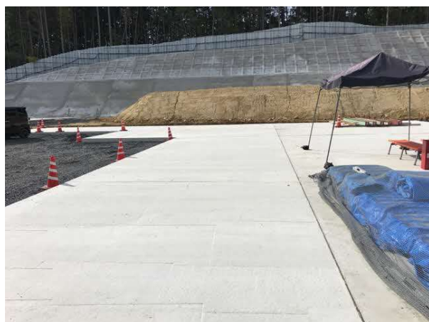
写真 ヤード舗装状況
