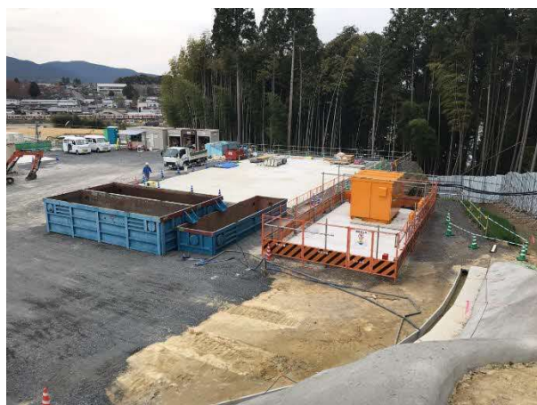
写真 基礎工状況
