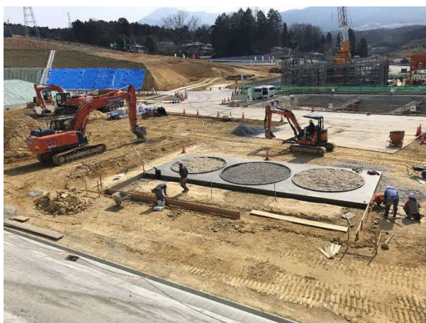
写真 基礎工状況
