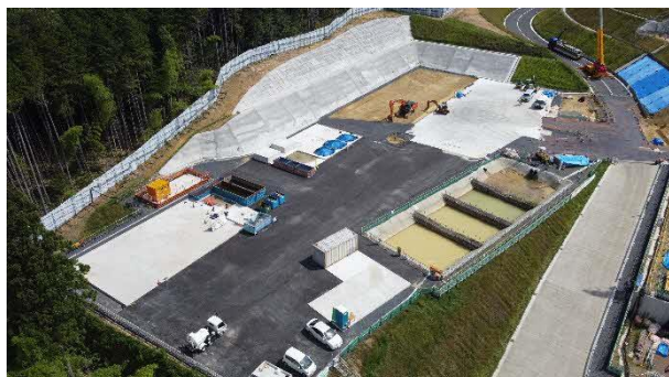
写真 ヤード造成状況
