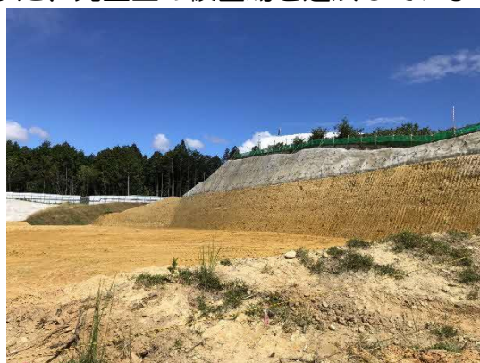
写真 坑口 2 段目掘削完了
