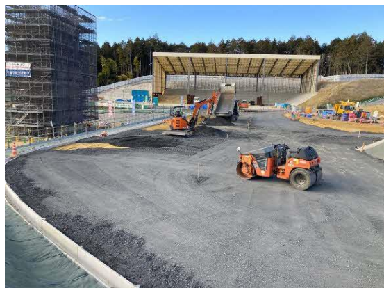
写真 ヤード舗装工事状況
