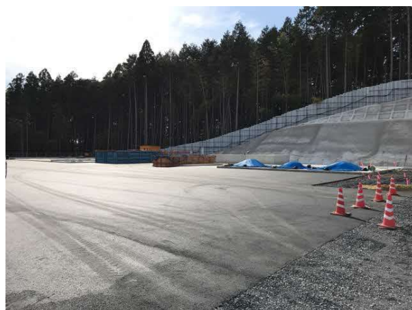
写真 ヤード舗装状況
