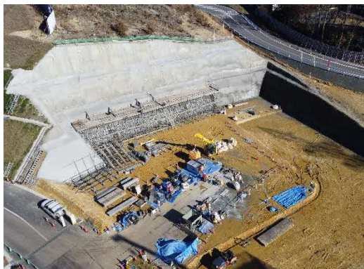
写真 坑口 3 段目 法面对策工施工状況
