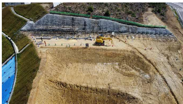
写真 坑口付近法面補強状況
