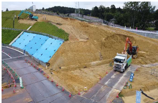
写真 坑口付近掘削状況
