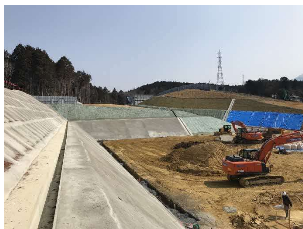
写真 法面吹付状況
