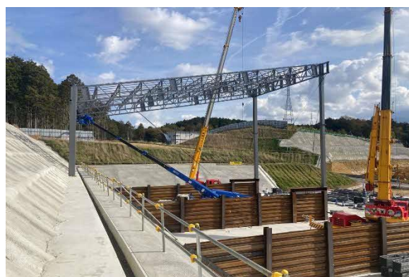
写真 発生土仮置場施工状況
