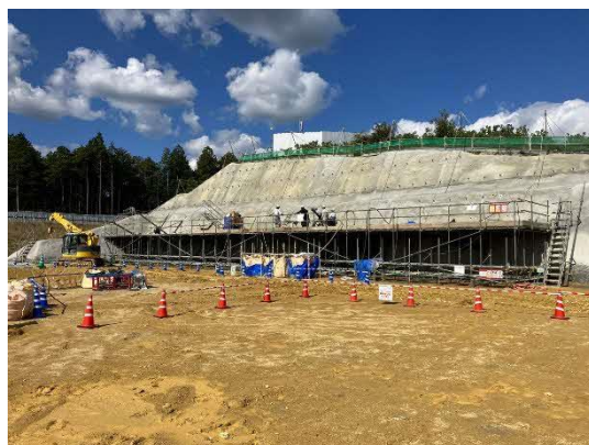
写真 坑口 2 段目 法面对策工施工状況
