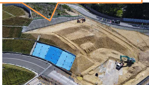
写真 坑口付近切土状況
