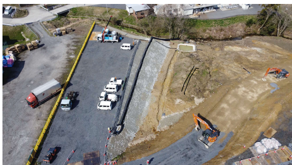
写真 工事用道路状況
