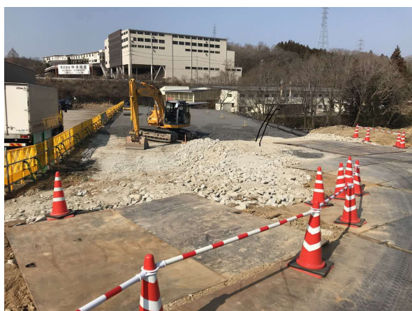
写真 盛土状況
