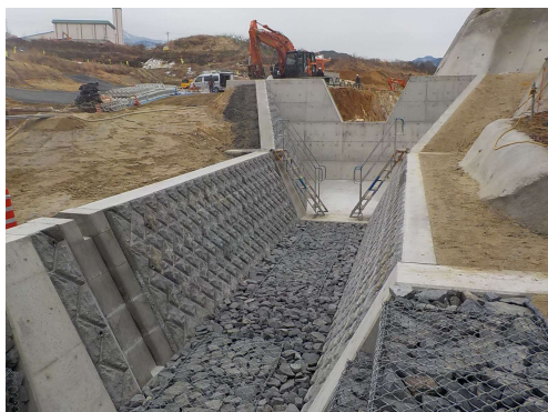
写真 河川付替え状況
