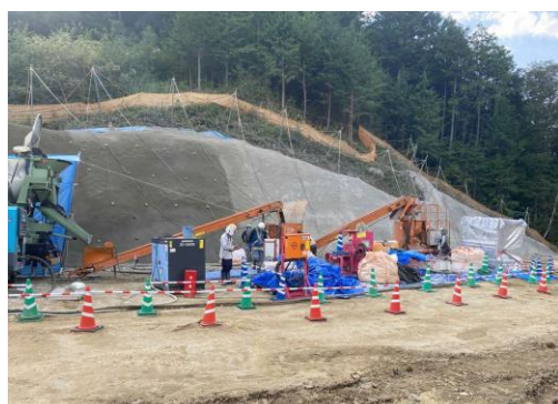
写真 法面对策工
