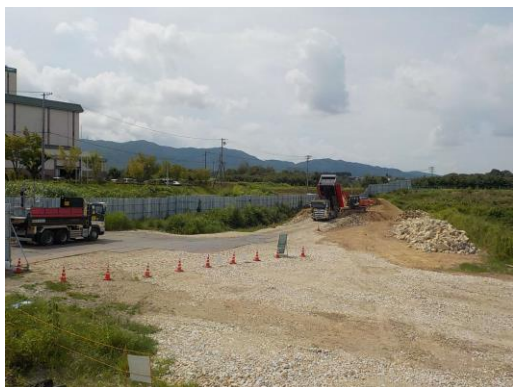
写真 発生土受入状況
