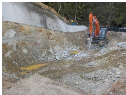
写真 付替河川掘削状況
