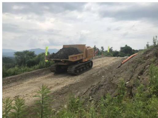
写真 表土運搬状況
