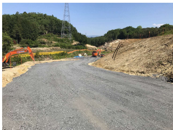
写真 工事用道路状況 【工事工程】
