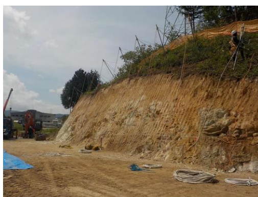
写真 法面对策工
