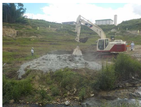
写真 表土改良状況
