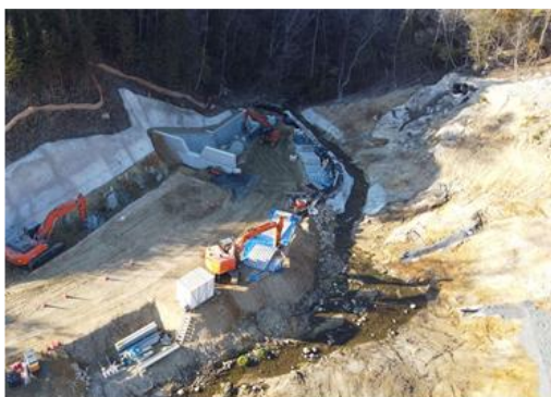
写真 河川付替え状況
