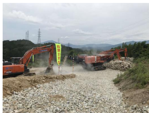
写真 支障物撤去状況
