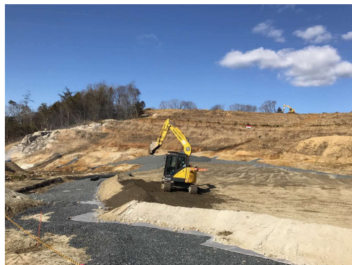
写真 盛土状況
