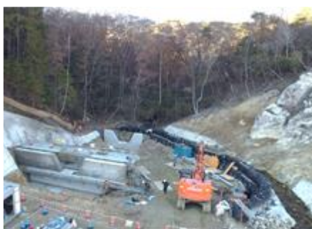
写真 付替河川施工状況
