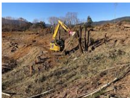
写真 ヤード北側伐採状況
