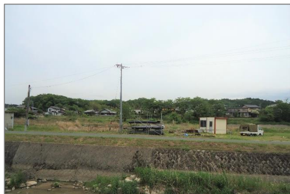
R3.5.12 時点 (着工前)
