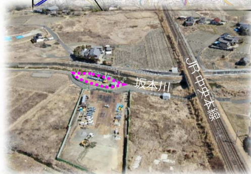
茄子川地区の橋梁工事状況 R5.3.6 現在
