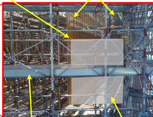
足場 ※手が届かない場所の 作業をするための足場
