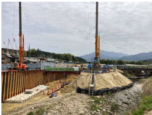
写真 河川切回し工 施工状況
