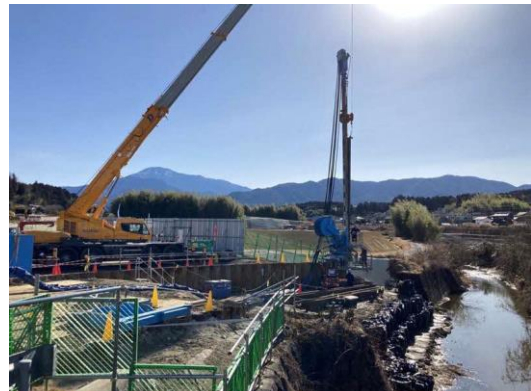
写真 仮付替河川 鋼矢板打設状況
