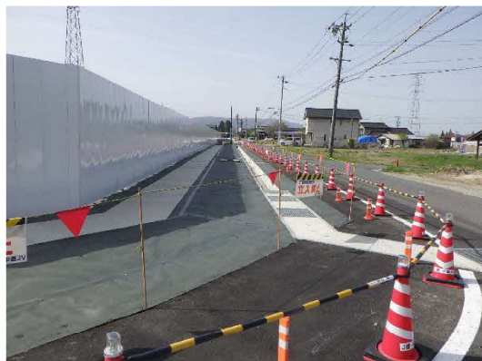
付替水路道路工事状況
