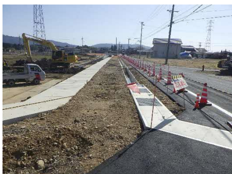
付替水路道路工事状況
