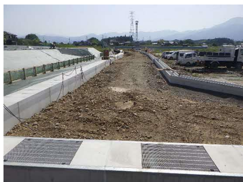
付替水路道路工事状況
