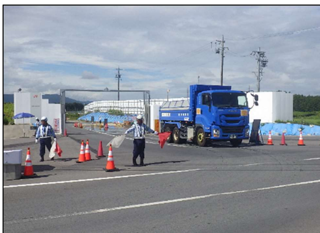
【進出入路仮設ゲート・発生土受入】
