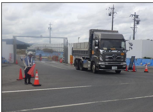
【進出入路仮設ゲート・発生土受入】
