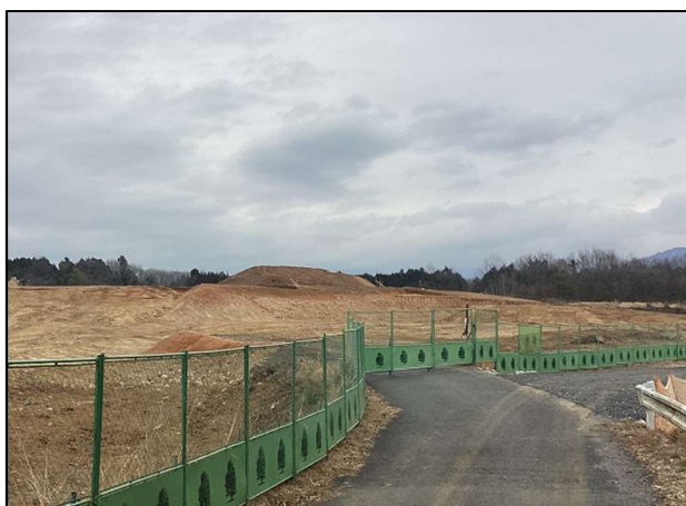
【施工状況・表土すきとり】
