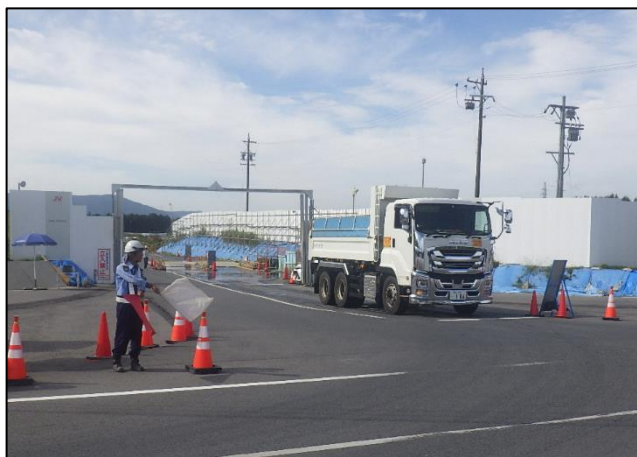
【進出入路仮設ゲート・発生土受入】
