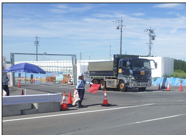
【進出入路仮設ゲート・発生土受入】
