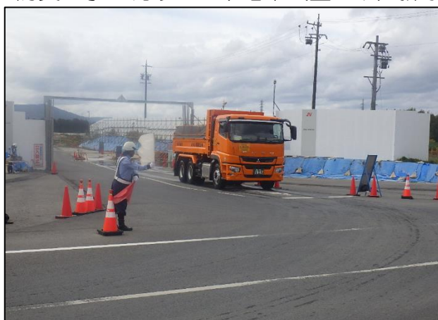
【進出入路仮設ゲート・発生土受入】
