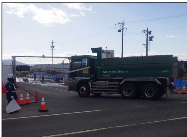
【進出入路仮設ゲート・発生土受入】
