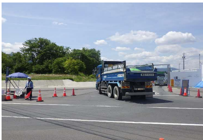
【進出入路仮設ゲート・発生土受入】
