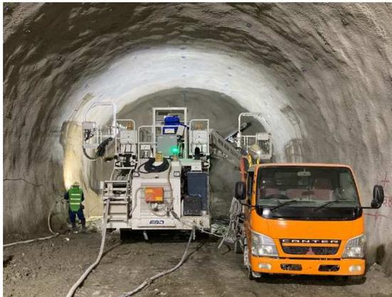
写真-1 ロックボルト打設状況
