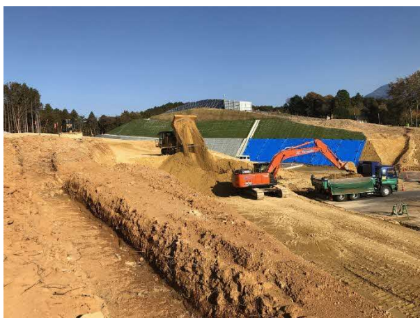
写真 掘削残土運搬状況
