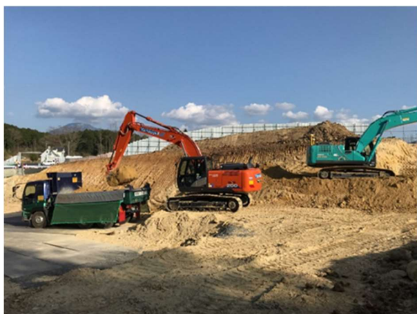
写真 掘削土積み込み状況
