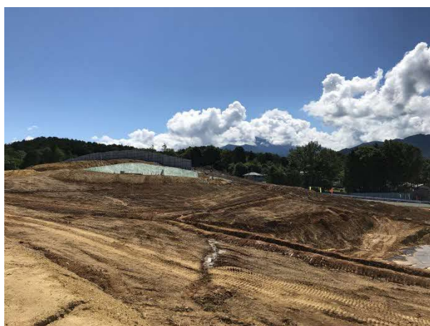
写真 ヤード造成状況
