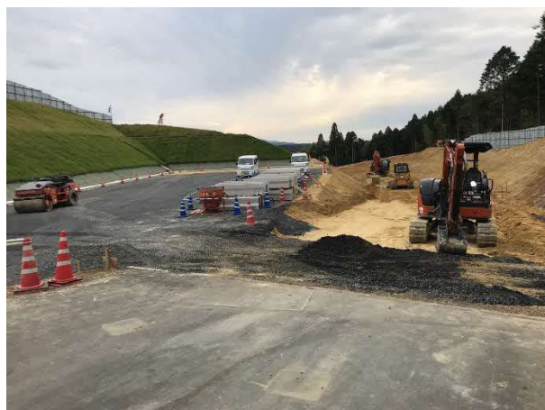
写真 ヤード造成状況
