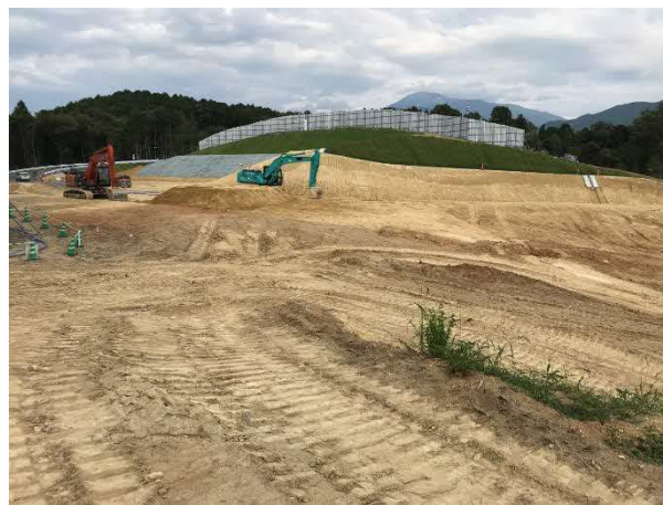
写真 ヤード内掘削状況
