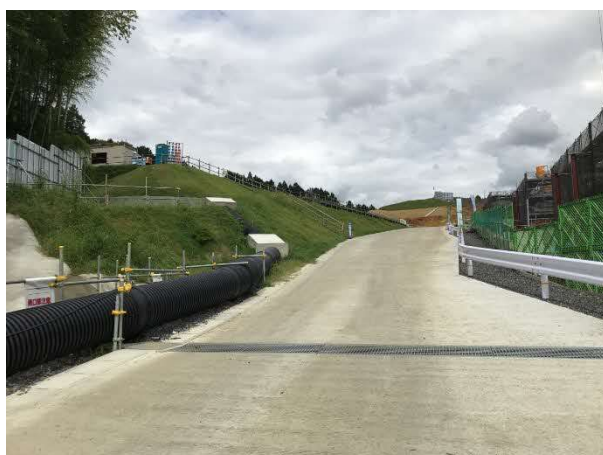
写真 法面緑化状況
