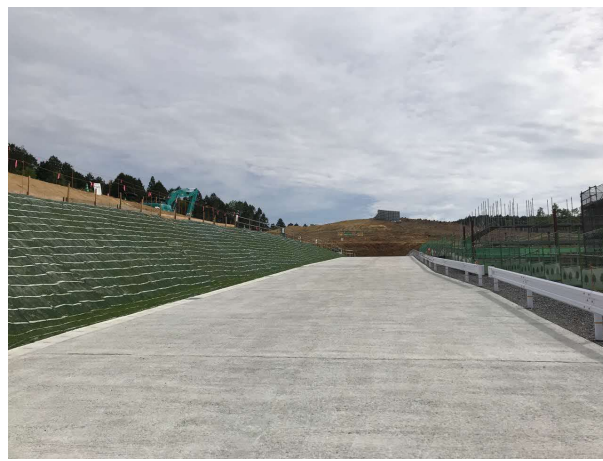
写真 進入路整備状況
