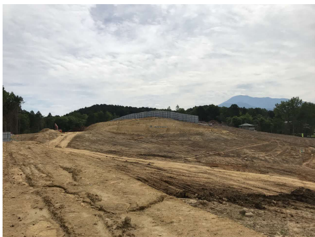
写真 ヤード造成状況
