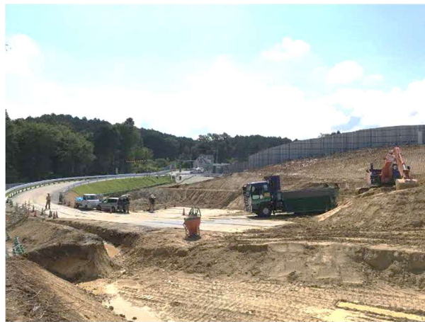
写真 掘削土の積込状況
