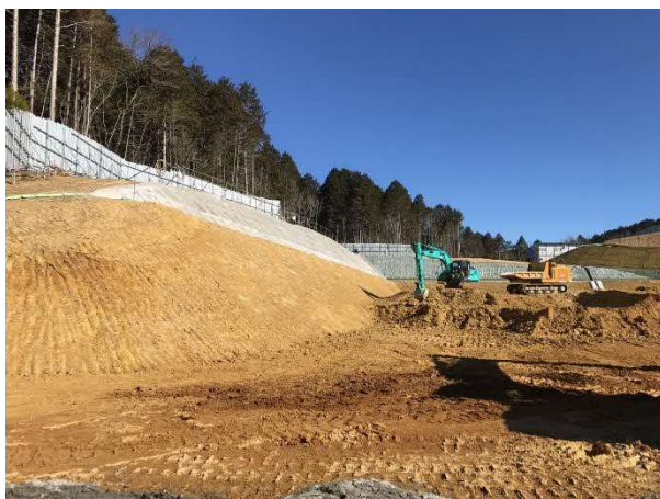
写真 切土施工状況
