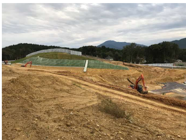
写真 法面緑化状況
