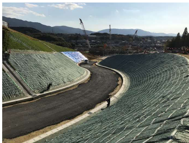
写真 工事用道路状況
