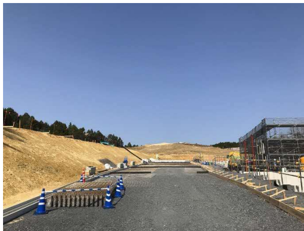
写真 進入路整備状況
