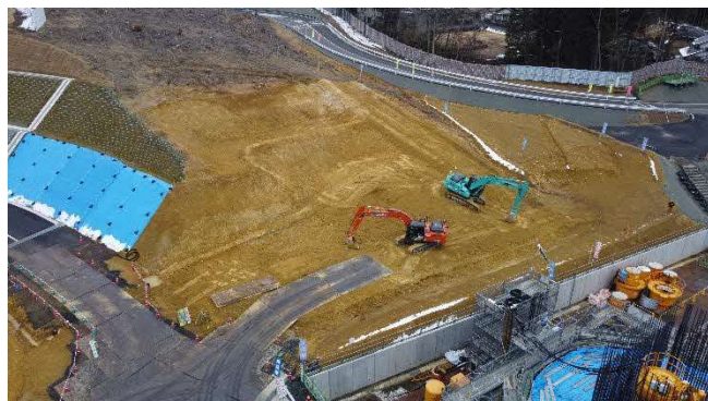
写真 切土施工状況
