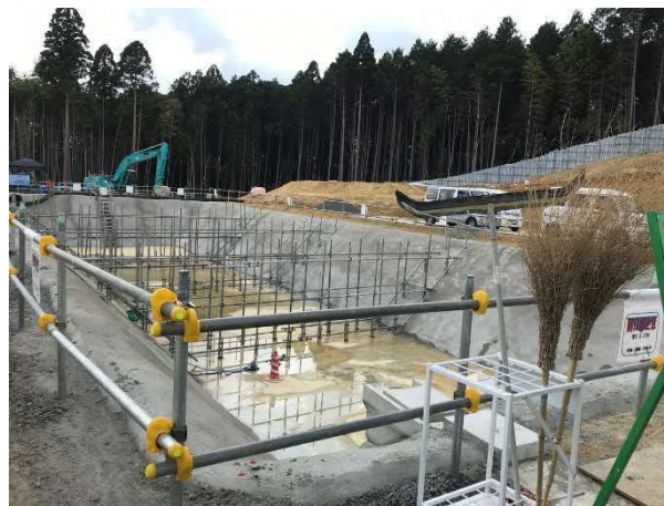
写真 沈砂池整備状況
