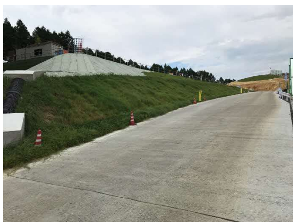
写真 法面緑化状況
