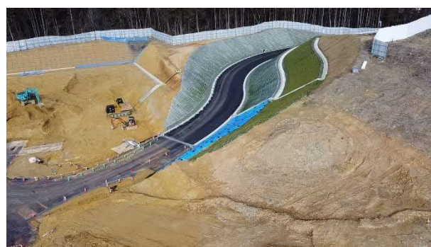
写真 工事用道路状況
