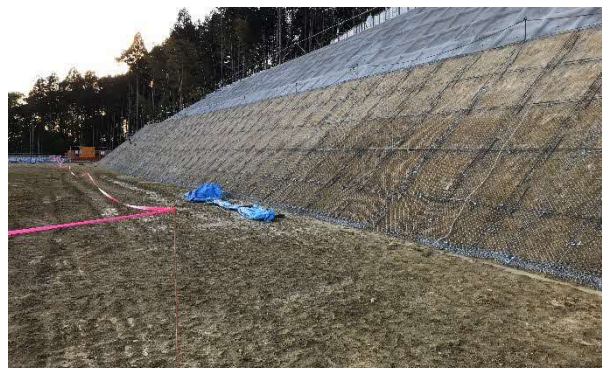
写真 法面整備状況
