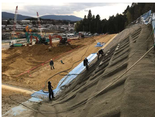
写真 法面吹付状況
